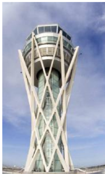
Vista parcial de la nova Torre de Control
